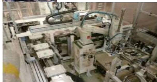
《リチウムイオン電池モジュール組立設備》
